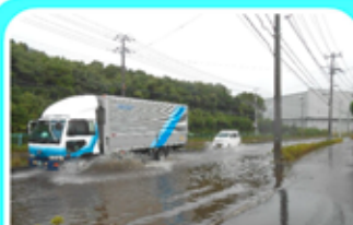
2013.10園前道路の冠水
