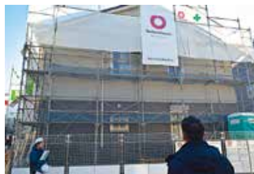
大久保ホーム A・B棟建設
